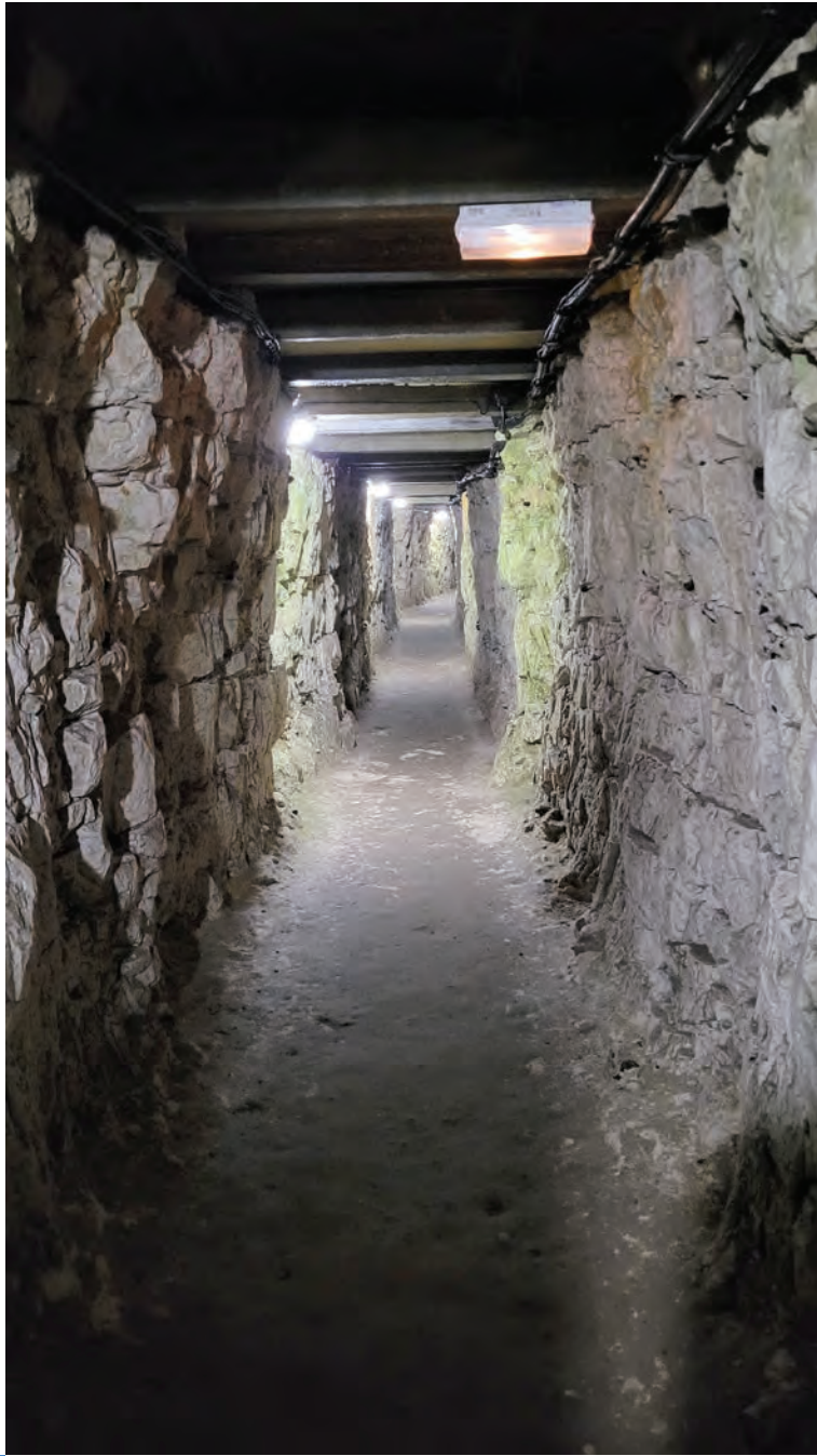
Vimy Ridge Grange Subway tunnel Le souterrain Grange à la crête de Vimy
